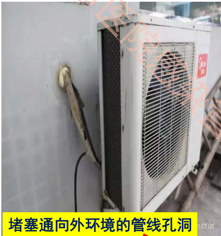
未堵塞通向外环境的管线孔洞
