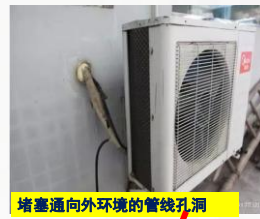
未堵塞通向外部环境的管线孔洞
