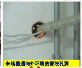
堵塞通向外部环境的管线孔洞
